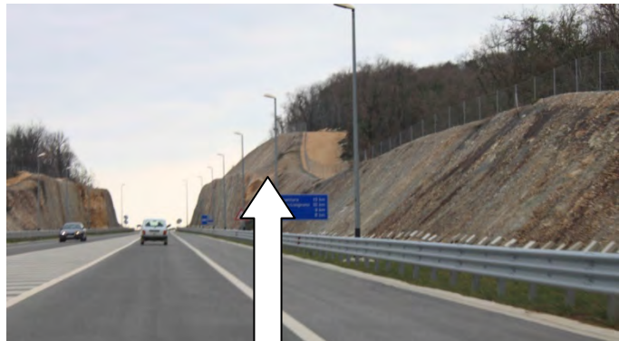
Schnellstraße geradeaus Richtung Premantura (2)
